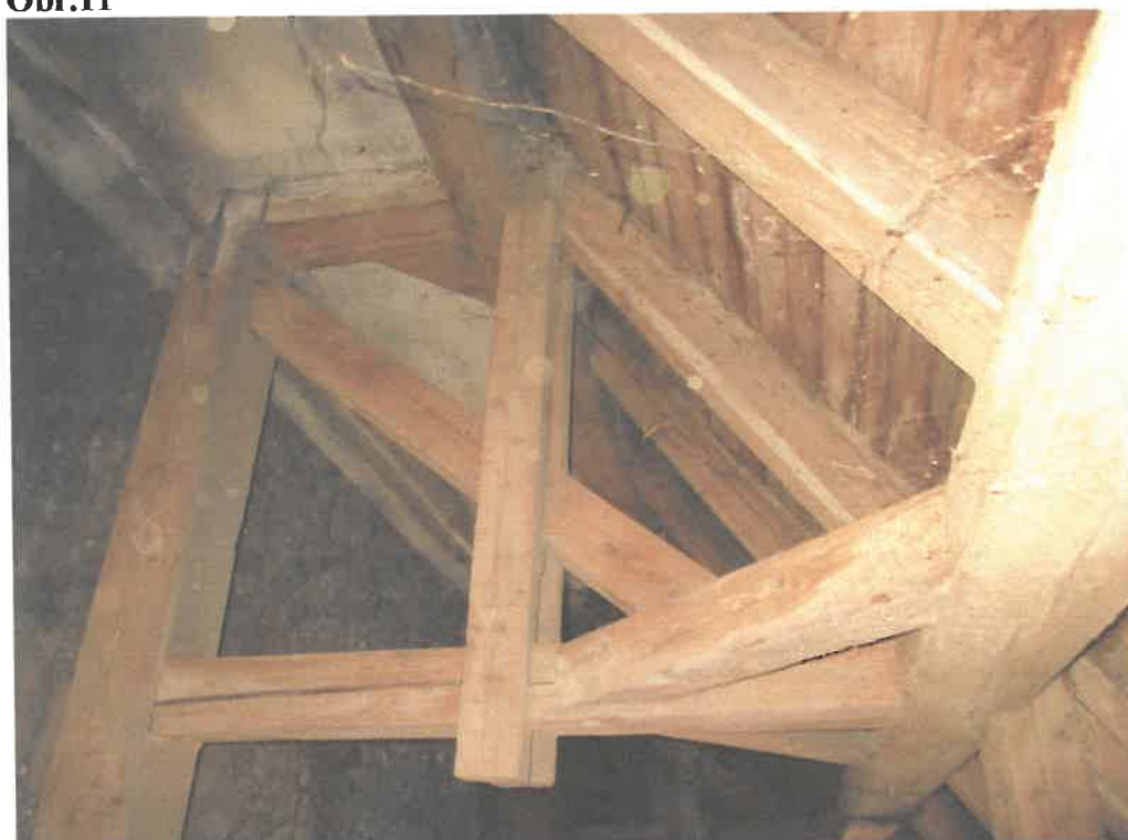
Rozchlupacení povrchu prvků chemickou korozí dřeva
